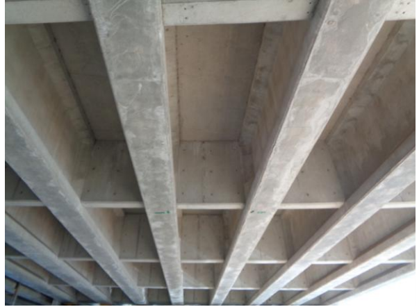
바닥판하면, 거더 전경
